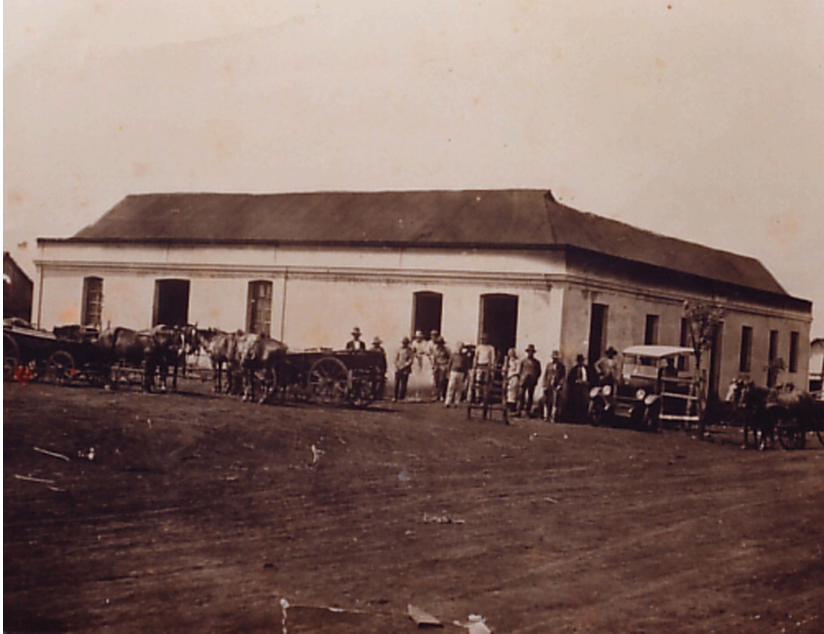
Prédio de Olintho Queiroz, onde hoje é a esquina da loja Vesti Modas
